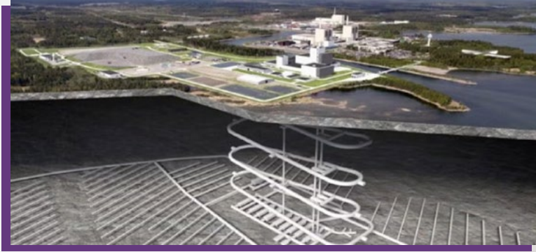
Şekil 7. Yüksek seviyeli radyoaktif atıklar için derin jeolojik/meden bertaraf tesisi (Sö-derviken-İsveç) (Energy Monitor, 2025)
